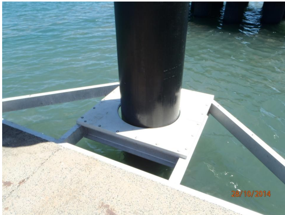
Pontoon pile guide
